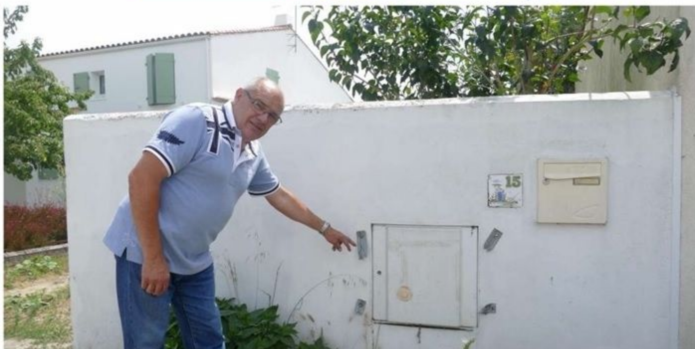
▲ Jean-Claude Guilbon devant le disjoncteur installé sur un muret de son domicile. ©MC.ARISTEGUI@SUDOUEST.FR
