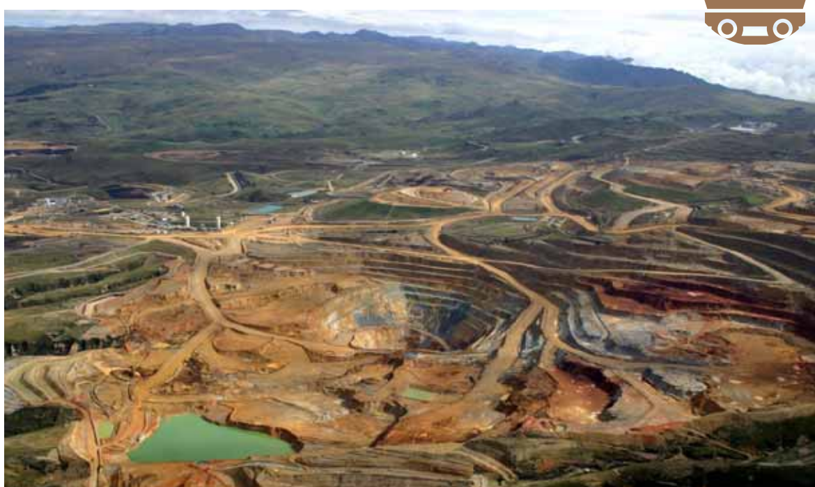
La mine d'or à ciel ouvert de Yanacocha, au Pérou, a été créée à l'initiative du BRGM français, un établissement public qui s'en est retiré dans les années 90. © CC BY-SA 3.0
