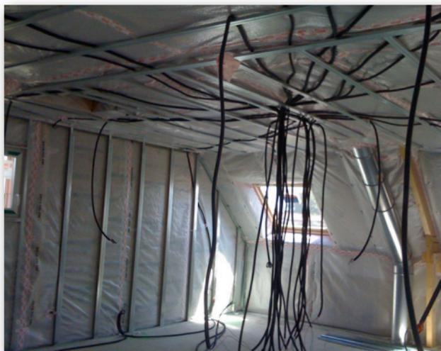
Installation d'un circuit électrique dans une maison
